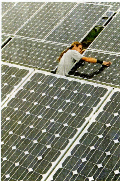
Ein Monteur überprüft Platten einer Solaranlage. Ökostrom beschäftigt auch die Justiz. Foto: dpa
