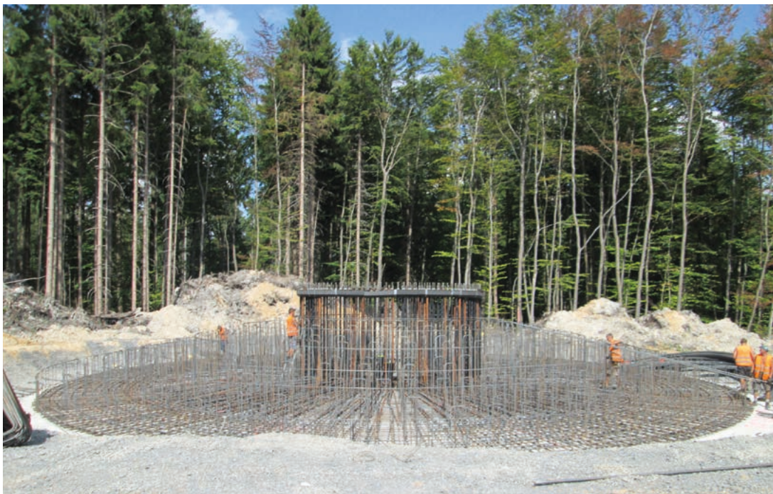
Abbildung 2: Bau des Fundaments einer Windenergieanlage in einem südhessischen Waldgebiet (Quelle: BDL Baudienstleistungen Untermain GmbH)
