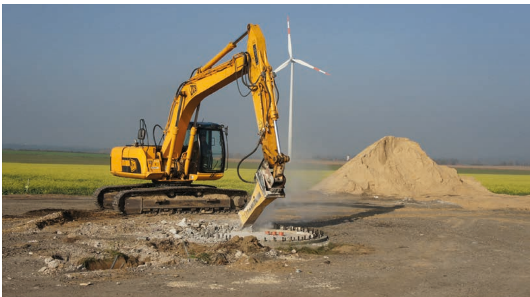
Abbildung 8: Rückbau des Fundaments einer Windenergieanlage mit Hilfe eines Hydraulikhammers (Quelle: NOTUS energy Potsdam)
