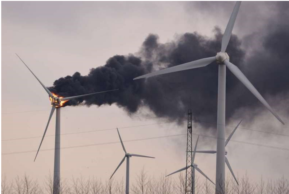
Abb.14: Im Windpark Oederquart nahe der Elbmündung gab es am 4.4.2016 einen typischen Brand im Maschinenhaus einer 70 m hohen WKA. Die Feuerwehr musste tatenlos zuschauen. Quelle: Foto Dymek; Stader...Altländer Tageblatt.de
