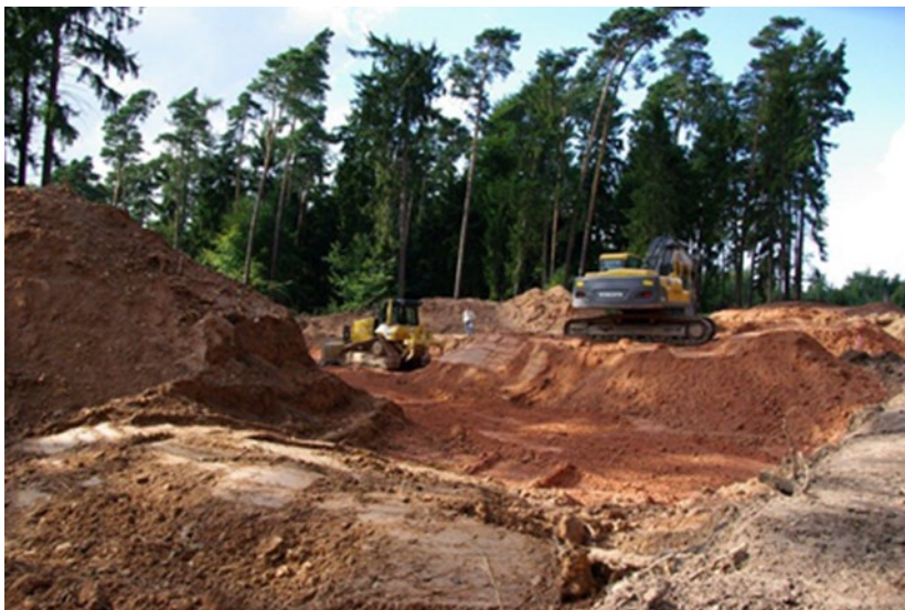
Abb. 11: Für die seit Kurzem in zahlreichen Bundesländern begonnene Errichtung großer Windkraftanlagen in Wäldern werden große Waldbestände zerstört, um die riesigen Bauteile an ihren Standort zu bringen. Hier eine solche Baumaßnahme im Odenwald.
