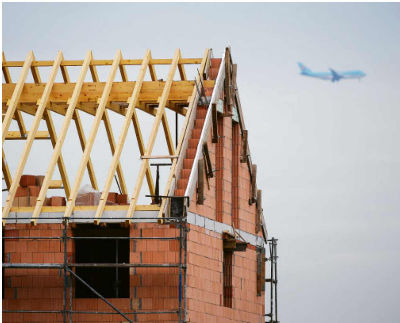
Rhein-Main baut: Der Ballungsraum ist ein Zugzugsgebiet – und braucht Platz für Wohnungen und Häuser.
