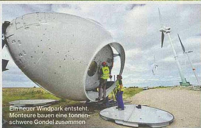
Ein neuer Windpark entsteht. Monteure bauen eine tonnenschwere Gondel zusammen
