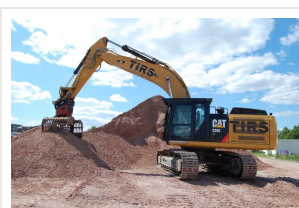
Bagger beim Abbruch- Foto:
