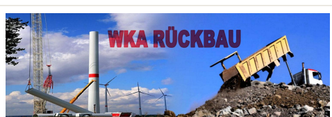
Rückbau Windkraftanlage- Foto: LKW: (c)
