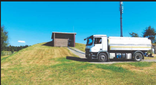
Ulrichstein: Ersatz-Wasserversorgung nach Trinkwasserkontamination durch WEA-Fundament
