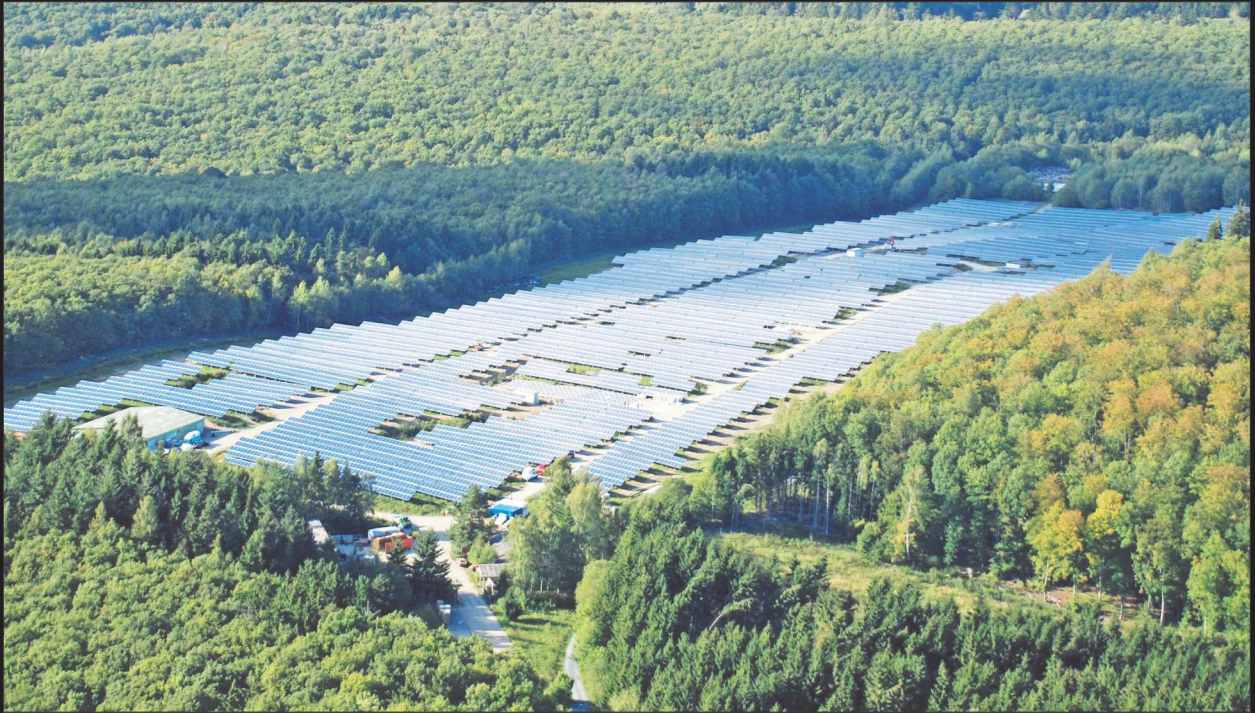
Freiflächen-Photovoltaikanlage Waldsolms - Die Lösung?
