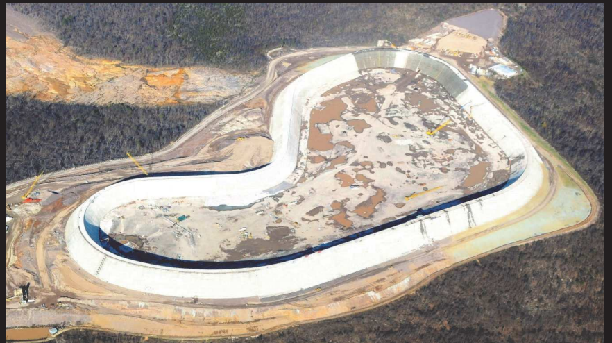
Oberbecken Pumpspeicherwerk Taum Sauk Missouri (US) nach Dammbbruch (2005) und Wiederaufbau (bis 2010)
